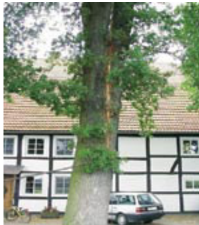
Schaden an einem Baum durch direkten Blitzeinschlag
