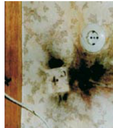
Wirkung von Blitzteilströmen
